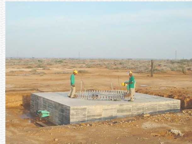
Fundación en fraguado
