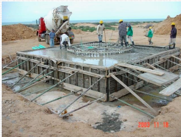
Vaciado del concreto
