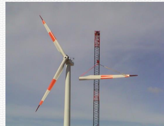
Montaje aerogeneradores
