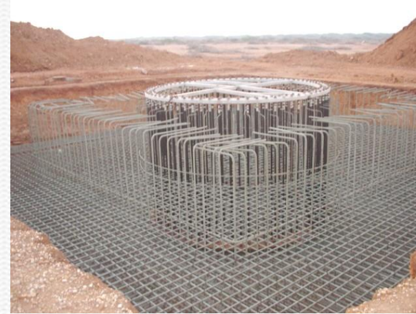
Colocación del refuerzo
